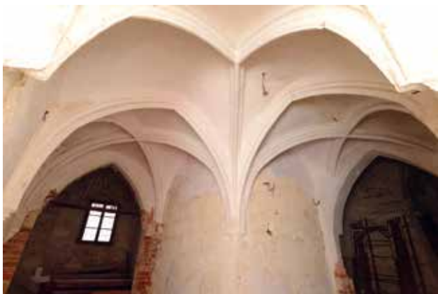
4 Gotički svod srednjovjekovnog samostanskog hodnika, u prizemlju zvonika (foto: J. Škudar, HRZ, 2014.)
