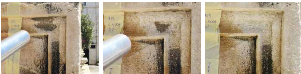
24 Probni postupak čišćenja laserom (foto: P. Ajduković, 2013.) Test laser cleaning procedure (photo: P. Ajduković, 2013)
