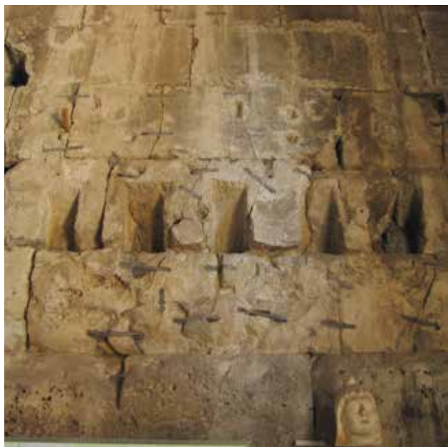
9 Istočni zid Augustova hrama, unutarnja strana. Zid s mjedanim klinovima, stanje u rujnu 2013. (foto: M. Špikić)
