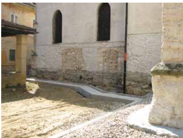
13 Zazidana vrata na vanjštini sjevernog zida svetišta i staza izvedena uz novoizgrađeni potporni zid uz sjevernu stranu crkve sv. Martina biskupa u Varaždinskim Toplicama, stanje tijekom radova 2011. godine (foto: M. Korunek)
