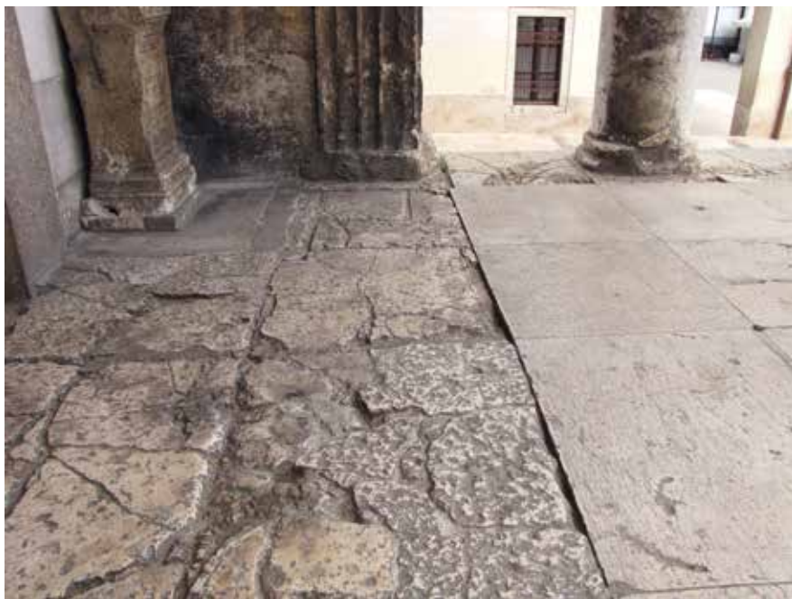
11 Popločenje pronaosa hrama, stanje u rujnu 2013. (foto: M. Špikić) Paving of the Temple pronaos , condition in September 2013 (photo: M. Špikić)
