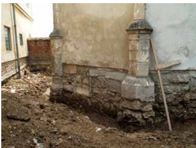
10 Donja zona zidova svetišta crkve sv. Martina biskupa u Varaždinskim Toplicama nakon uklanjanja betonskog kanala, stanje 2010. godine (foto: M. Korunek)
