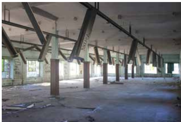
23 Tvornička hala u ugaonom dijelu zgrade na 2. katu (foto: M. Pretković, 2013.)
