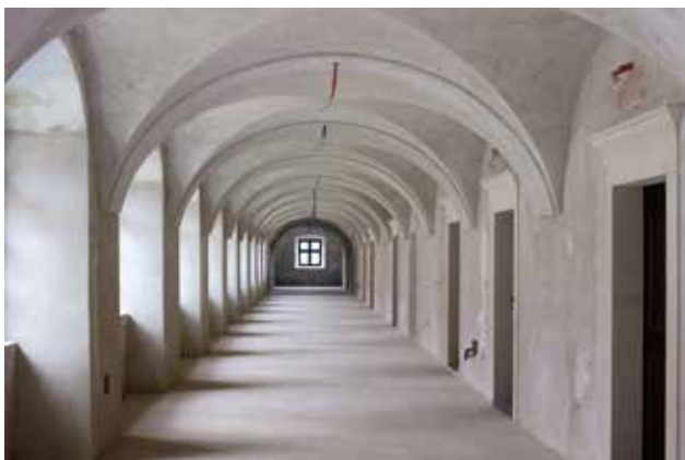
31 Hodnik prvog kata sjevernog krila samostana nakon prve faze obnove (foto: G. Tomljenović, HRZ, 2015.)
