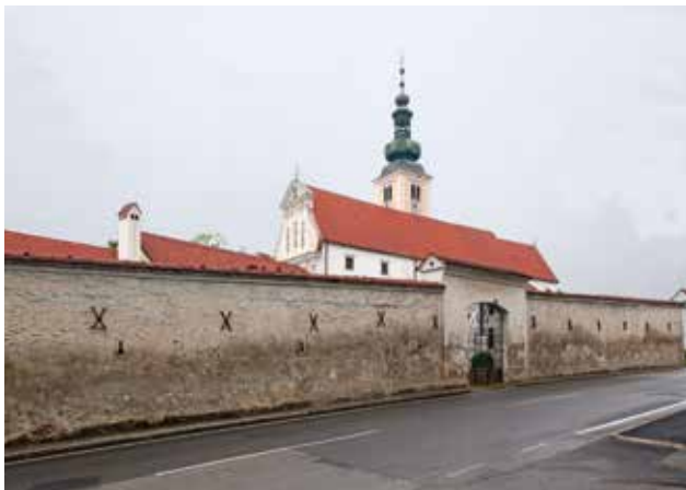
15 Dio sačuvanog obrambenog zida s južne strane kompleksa (foto: G. Tomljenović, HRZ, 2015.)
