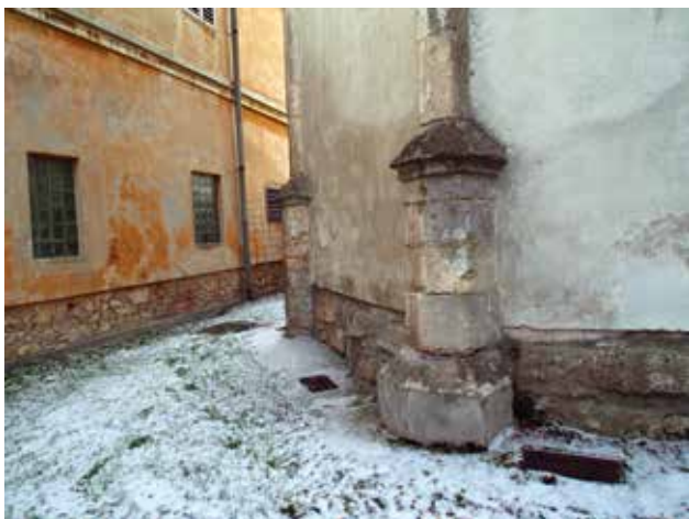
9 Betonski kanal uz zidove zaključka svetišta crkve sv. Martina biskupa u Varaždinskim Toplicama, stanje 2009. godine (foto: M. Korunek)
