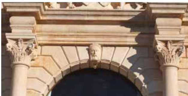
11 Detalj luka klesanog „bugnato“ klesancima sa zaglavnom kamenom ukrašenim reljefom ljudske glave (foto: Z. Bočina 2013.)
