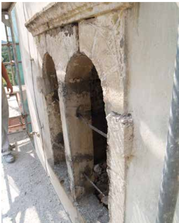
17 Bifora na zvoniku crkve sv. Martina biskupa u Varaždinskim Toplicama tijekom obnove, stanje 2011. godine (foto: M. Korunek) Bifora on the belfry of the church of St. Martin the Bishop in Varaždinske Toplice during restoration, condition in 2011 (photo: M. Korunek)
