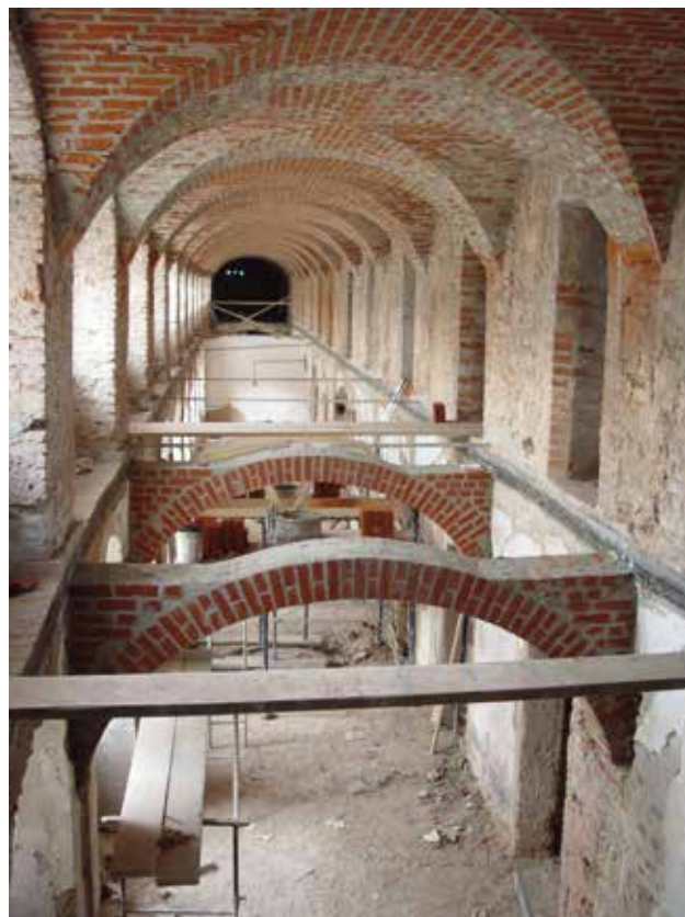
30 Zidanje svodova u sjevernom krilu samostana (foto: P. Puhmajer, HRZ, 2007.)
