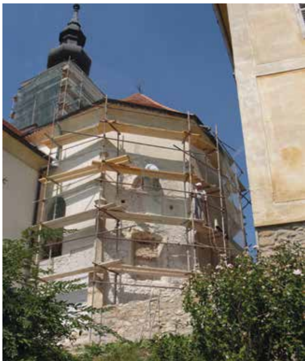
20 Pogled na svetište crkve sv. Martina biskupa u Varaždinskim Toplicama tijekom vađenja ispune kasnosrednjovjekovnih prozora, stanje tijekom obnove 2011. godine (foto: M. Korunek)
