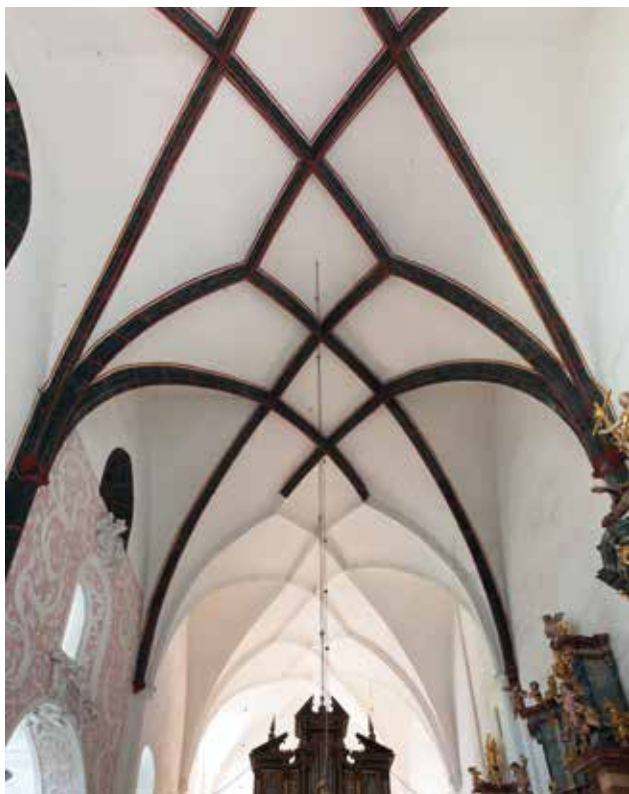
7 Svod lađe crkve. Presentacijom rebara s crnim obojenjem naznačena je razlika između izvornih gotičkih kamenih rebara i onih nastalih u 17. stoljeću (foto: G. Tomljenović, HRZ, 2015.)
