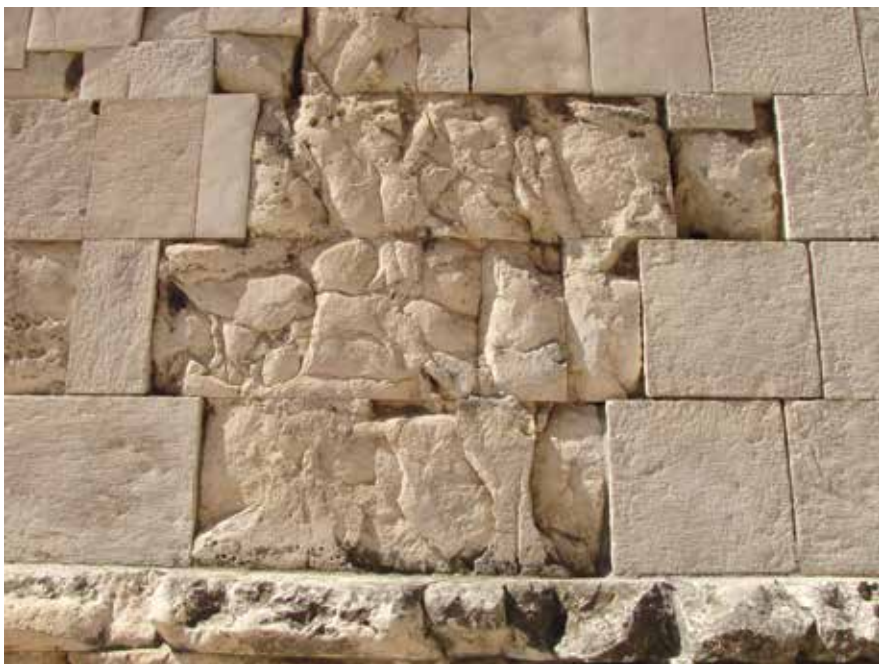
7 Istočni zid Augustova hrama, vanjska strana. Stanje u rujnu 2013. (foto: M. Špikić) Eastern wall of the Temple of Augustus, external side. Condition in September 2013 (photo: M. Špikić)
