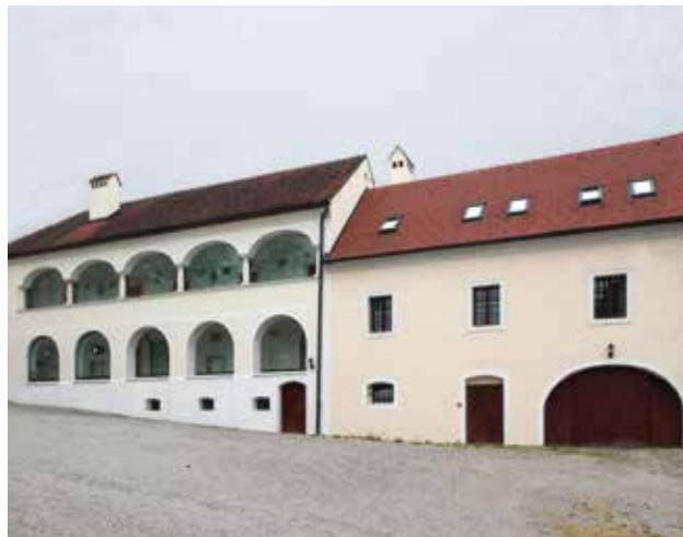
14 Zgrade pavlinskog gostinjca, danas župni dvor u Lepoglavi (foto: G. Tomljenović, HRZ, 2015.)
